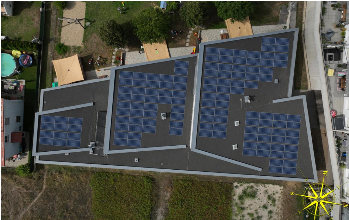
Abbildung 3 Anordnung der Solarmodule am Dach des Kindergartens Winzergasse
