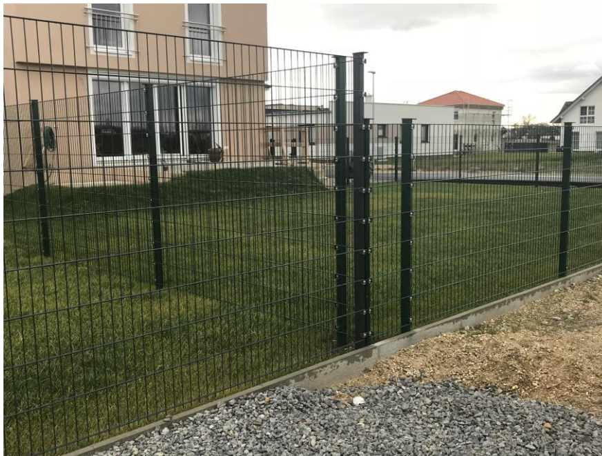
Abbildung 8: Doppelstabmattenzaun, keine bauliche Anlage
