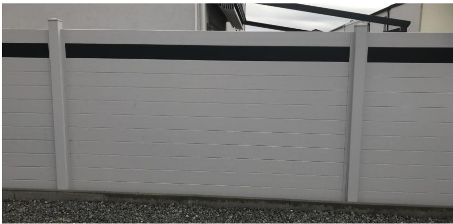
Abbildung 2: flächenbildender Aluminiumzaun, bauliche Anlage
