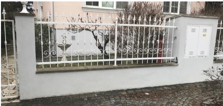
Abbildung 5: Sockel mit winddurchlässigem Zaun, keine bauliche Anlage (bezieht sich nur auf den Zaun)
