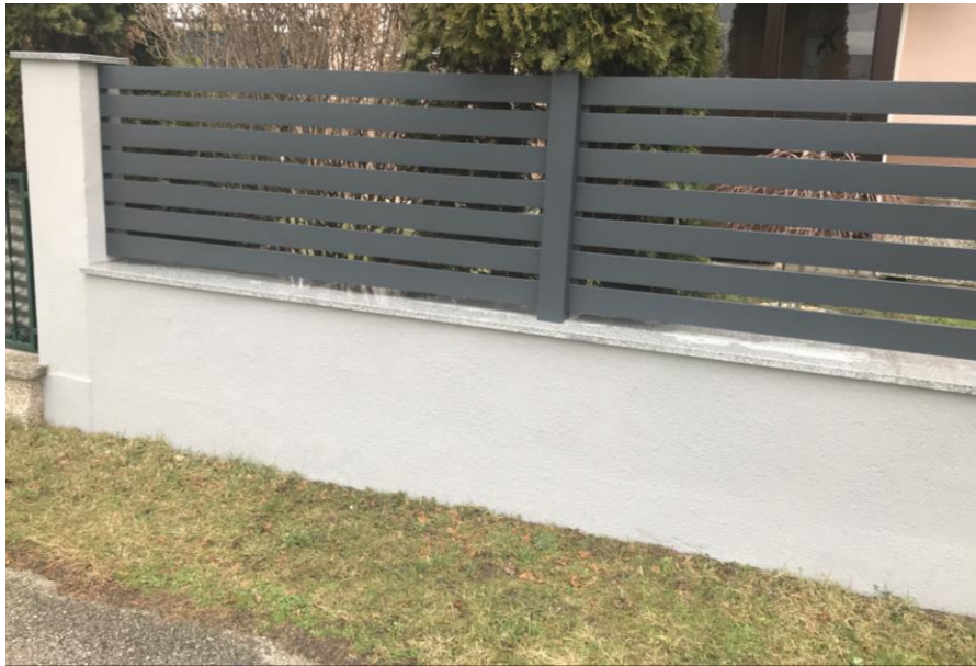
Abbildung 3: Mauersockel mit aufgesetztem Zaun, bauliche Anlage
