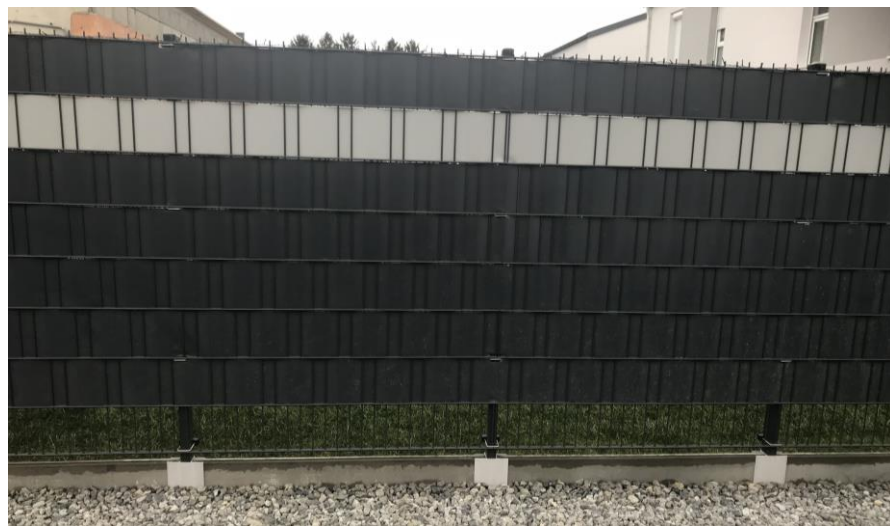
Abbildung 4: Doppelstabmattenzaun mit Sichtschutz, bauliche Anlage
