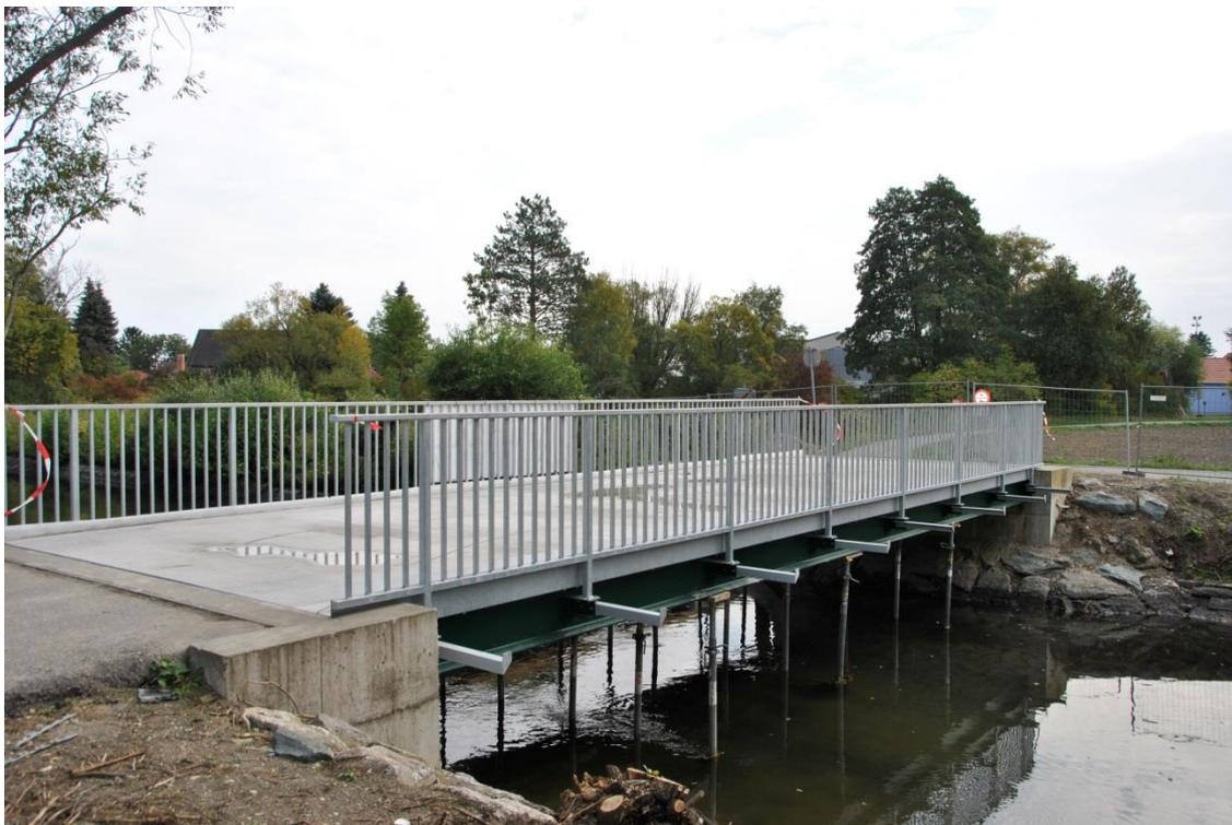
Durch die Verstärkung des Tragwerks und das Aufbringen von Betonplatten ist sichergestellt, dass diese nicht nur für lange Zeit sanierungsfrei bleibt, sondern auch von unseren Landwirten ohne Gewichtsbeschränkung genutzt werden kann. In Kürze kann auch wieder ein Ausflug zu Fuß oder per Rad ohne „Umleitung“ stattfinden.
