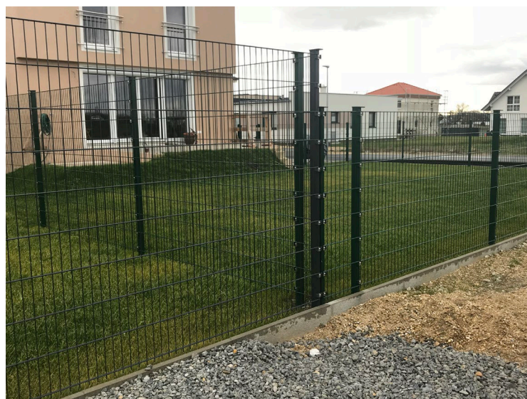
Abbildung 7: Doppelstabmattenzaun, keine bauliche Anlage
