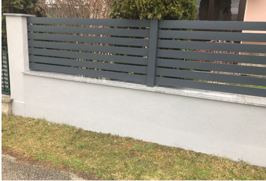
Abbildung 3: Mauersockel mit aufgesetztem Zaun, bauliche Anlage
