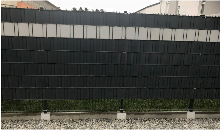
Abbildung 4: Doppelstabmattenzaun mit Sichtschutz, bauliche Anlage
